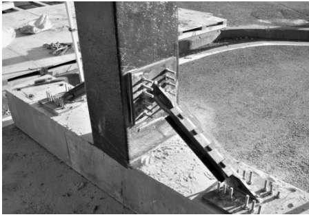
〈그림 3〉 FRP Sheet와 BRB가 모두 적용된 실험체
