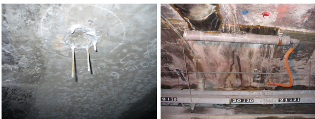
그림 1. 덕트부에 발생한 결정체 및 백색 침전물
