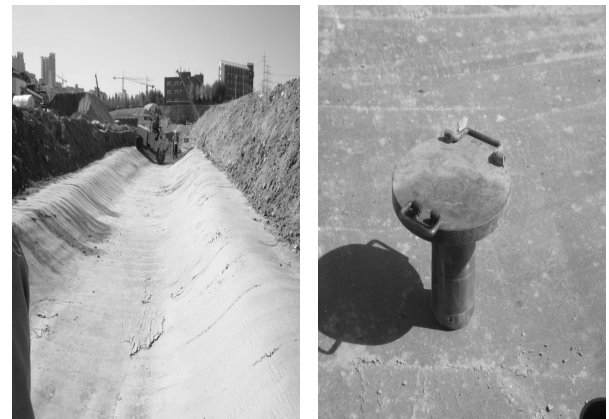
그림 6. 현장다짐 및 시료샘플 채취
