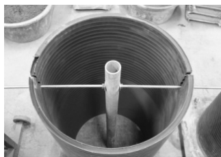
① 거푸집 설치
