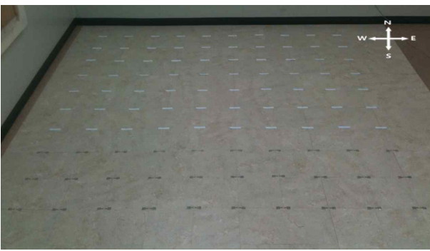
그림 5. 데코타일로 구성된 Smart Floor Fig. 5. Smart Floor by composed deco-tile.
