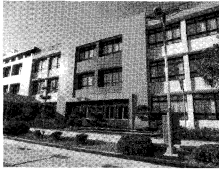
(c) 창호형 댐퍼 보강 완료 전경
