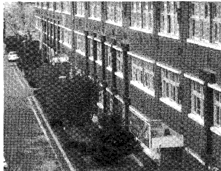
(d) 00초등학교에 설치된 SSF 댐퍼
