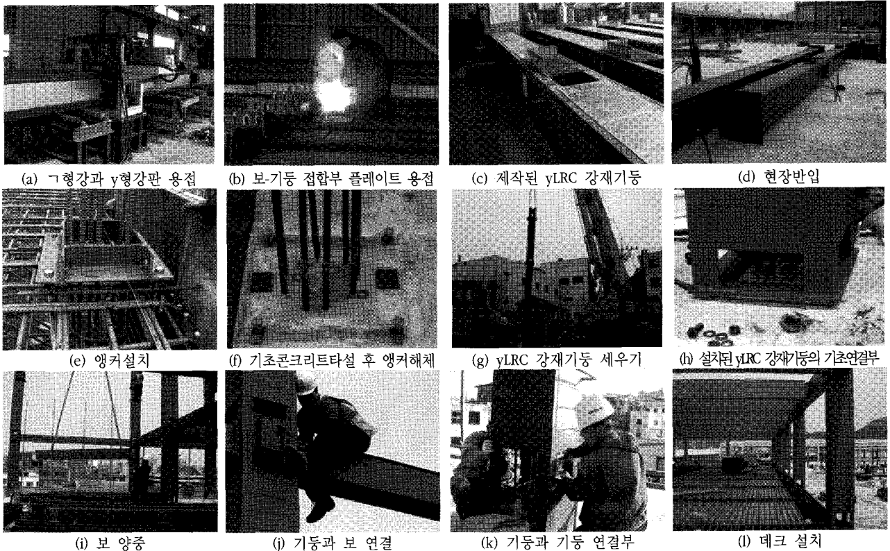
그림 10 yLRC 강재기둥의 제작 및 시공과정 (2층 사무동)
