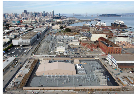
그림 3 Trans Bay Cable Project의 샌프란시스코 변환소 Fig. 3 Trans Bay Cable Project - San Francisco HVDC Converter Station
