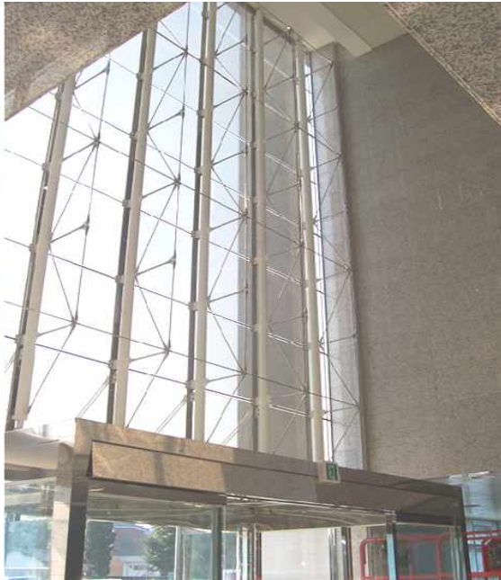
그림 9. K건설기술연구소 건물에 설치된 a-si계열 투명 박막 PV창 설치사례
