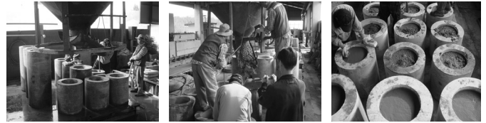
그림 5. 콘크리트 타설 및 면정리
