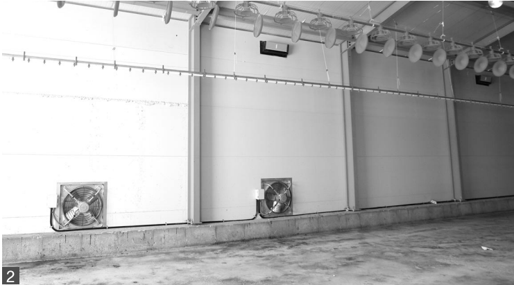
① 첫 출하를 한 초가농장 계사 내부 전경. 계사 2개동을 붙인 모형인 M자모양의 연동계사. 가로 폭을 확보해 계사설비 비용을 최소화해 계사당 입식수를 늘릴 수 있다는 것이 장점. 1개동 당 4만수 입식가능 ② 계사 옆면에 환을 설치해 환기하는 크로스 환기 시스템 ③ M자 모형 연동계사는 천정에 고인 물이 쌓이지 않고 아래로 흐를수 있게 물 배수로를 만들어 폭우로 인한 피해를 줄였다. ④ 겨울철 온도 유지를 위해 온풍기 설치
