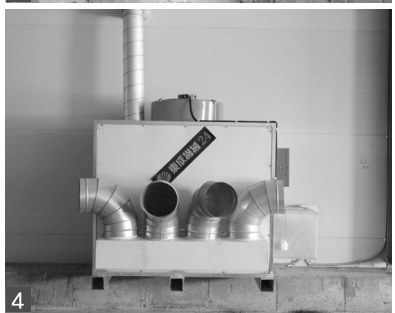
① 첫 출하를 한 초가농장 계사 내부 전경. 계사 2개동을 붙인 모형인 M자모양의 연동계사. 가로 폭을 확보해 계사설비 비용을 최소화해 계사당 입식수를 늘릴 수 있다는 것이 장점. 1개동 당 4만수 입식가능 ② 계사 옆면에 환을 설치해 환기하는 크로스 환기 시스템 ③ M자 모형 연동계사는 천정에 고인 물이 쌓이지 않고 아래로 흐를수 있게 물 배수로를 만들어 폭우로 인한 피해를 줄였다. ④ 겨울철 온도 유지를 위해 온풍기 설치
