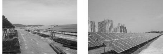
Fig. 12 고정식 어레이 설치 모습
