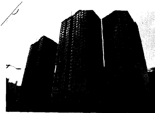
사진 5. 화재가 발생한 주상복합 건물
