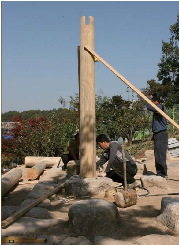
【 사진 3 】 기둥 가조립 세우기
