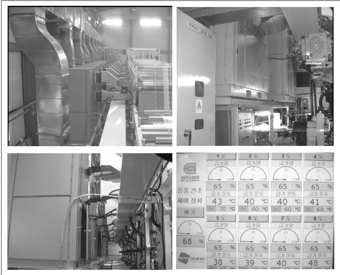
[사진 6] 이 세이버 설치 사진
