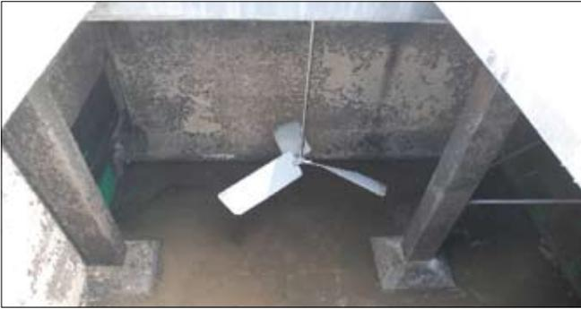
입축프로펠러형(Hydrofoil Type) 교반기 설치 모습(내부)
