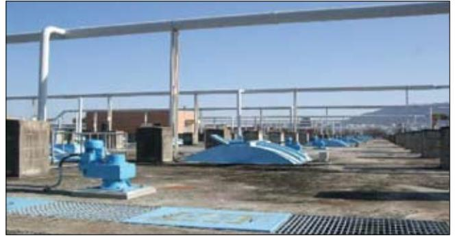
입축프로펠러형(Hydrofoil Type) 교반기 설치 모습(외부)
