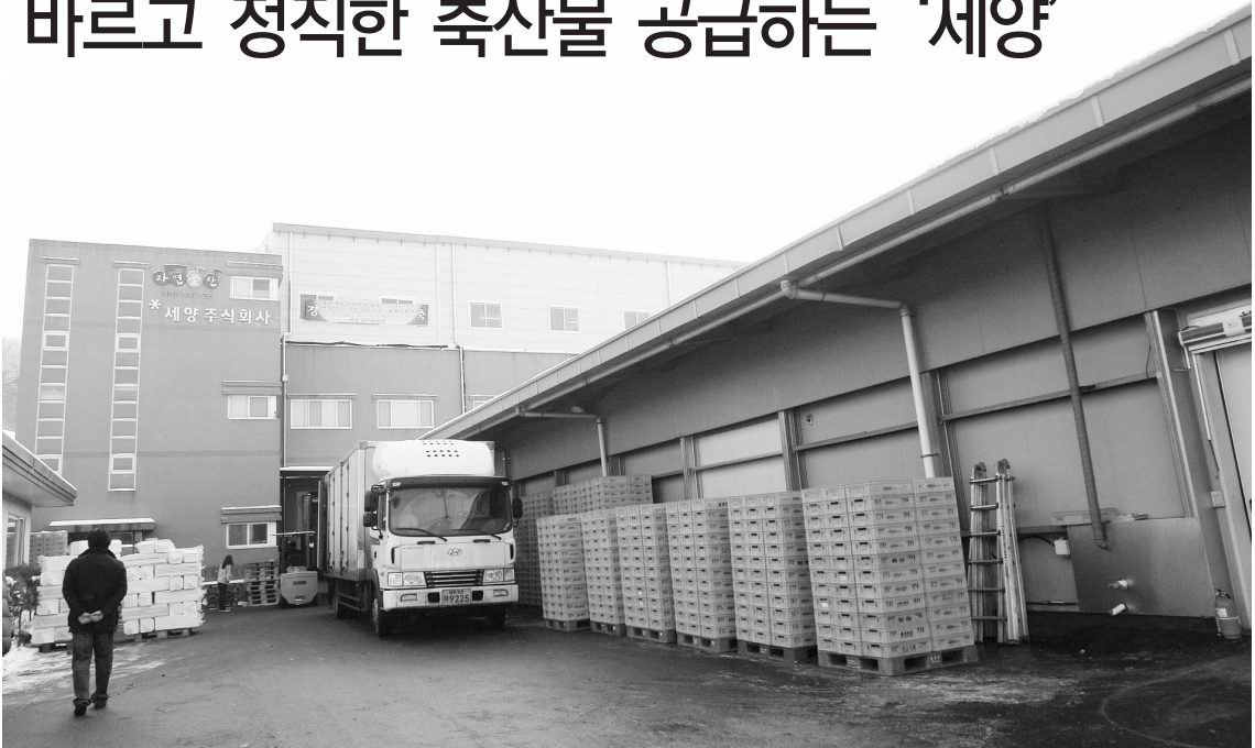
▲ 세양 주식회사 전경-제품출하실(1층), GP센터(2층), 구운·훈제란 생산라인(3층)
