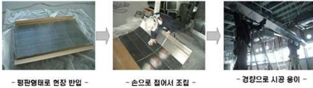
그림 8. 친환경 골판지덕트의 시공
