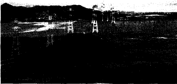
345kV 영흥 해상 송전철탑
