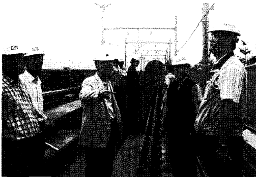
• 공항철도 2단계 구간 예비준공검사를 실시한 안무영 전문위원(우측 2번째 인물은 협회회원인 KCC 박규수 현장소장)
