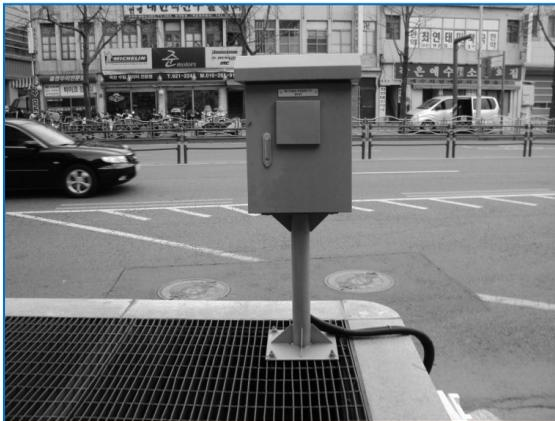
그림 5. 전력사용량 측정 패널
