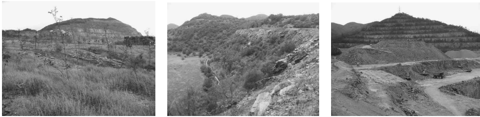
그림 13. 채석과 복원이 동시에 진행되고 있는 Anderson Road 채석장의 전경(채석지 바닥과 채석잔벽의 복원, 좌), Lamma 채석장 잔벽 식생복원 상황 근경(소단과 하단에 수로설치, 교목과 관목 식재, 중), 채석완료 잔벽의 식생복원과 채석이 진행되고 있는 Lam Tei 채석장의 전경(우).
