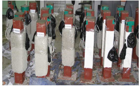
그림 1. 콘크리트가 충전된 시험체 제작모습
