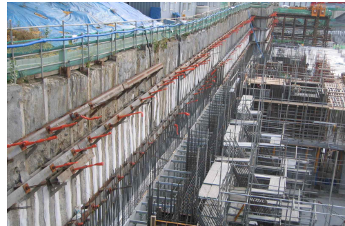
사진 4. 외벽부분의 공사 전경
