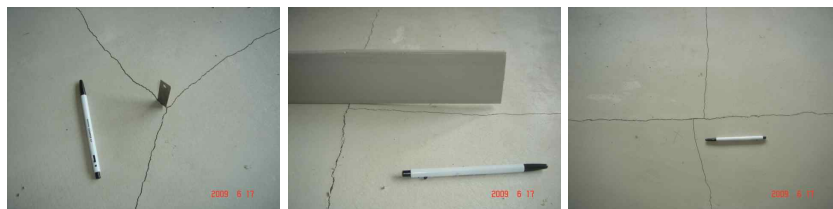
(a) 60 mm 완충재 + 일반 건조 레미탈(108동) (b) 60 mm 완충재 + 일반 건조 레미탈(108동) (c) 60 mm 완충재 + 일반 건조 레미탈(110동)
