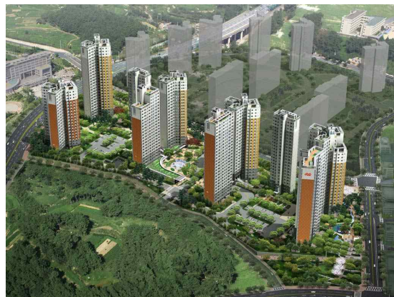
그림 4. 완공 후 현장 조감도
