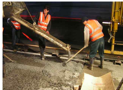
사진 2. 콘크리트 덧씌우기 포설 전경
