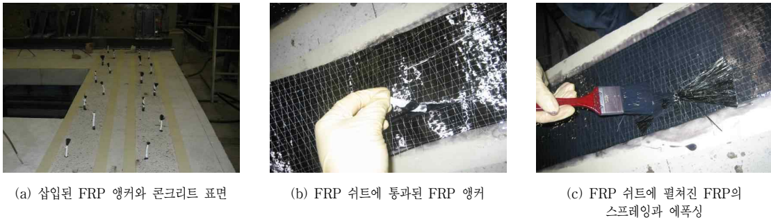
그림 3. 슬래브 S7의 FRP 보강과 FRP 앵커 설치
