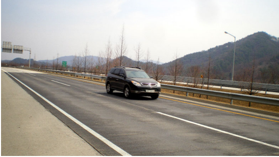
그림 4. 박층용 APC 시공 완료
