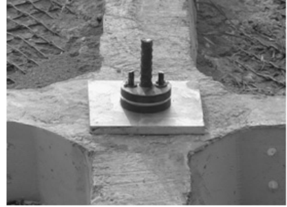
(f) 지압판 설치 및 표면처리
