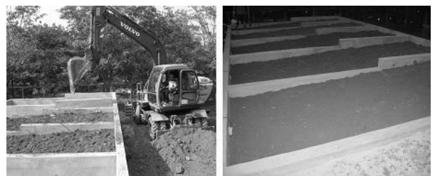
그림 3. 토조 내 복토재료 충전 전경
