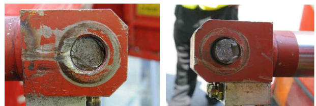
(d) Fracture section of failure pin
