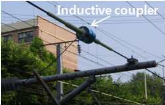
그림 4. 조가선에 달린 비접촉식 신호 결합기 Fig. 4. ICU on messenger wire
