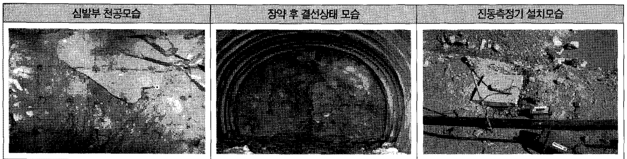
그림 6. 시험발파 모습
