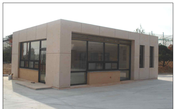
그림 1. 황토콘크리트 시공 건물
