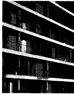
<그림 8> 취리히 Brunnenhof아파트, Adrian Schiess의 파사드 색채
