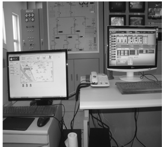
그림 6. 빗물펌프장 운영 프로그램 및 MMI 설치 사진
