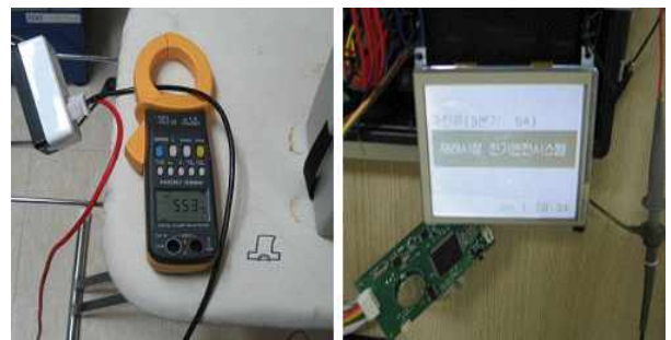
그림 4 과부하 발생 및 분전반 LCD에 경고 분기 표시 Fig. 4 Overcurrent generation and LCD warning display
