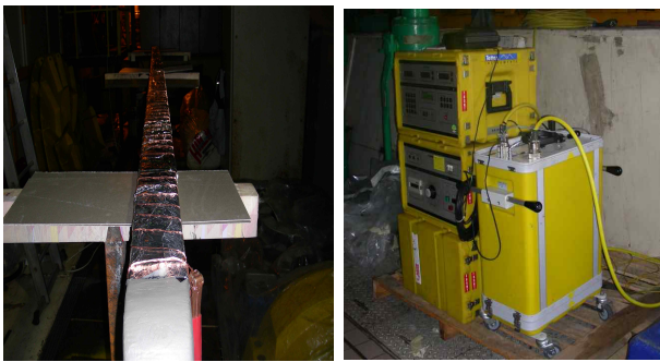
그림 10 수리완료한 권선의 내전압 시험 Fig 10 AC endurance test for repaired bar
