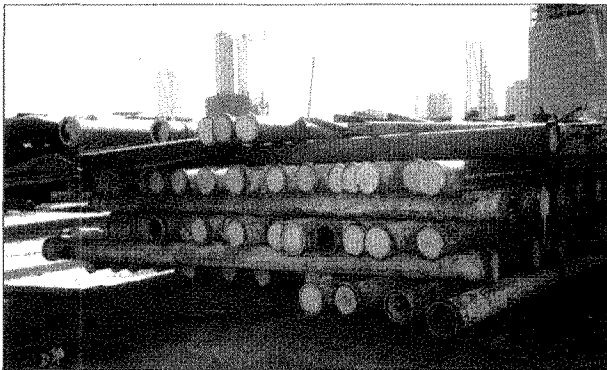
그림 1. 콘크리트 폐색으로 폐기된 배관
