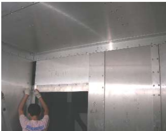
그림 3. 알루미늄 차폐실 제작과정 Fig. 3. Aluminum MSR Manufacture Processing
