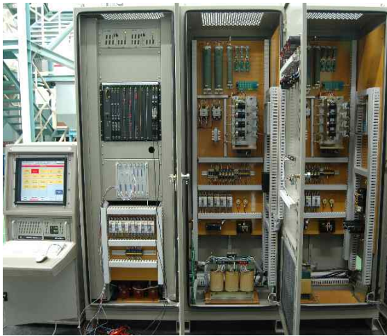
그림 14. 회생형 이중화 PWM 디지털 여자시스템 사진 Fig. 14. The picture of dual PWM digital excitation system with auto regeneration type
