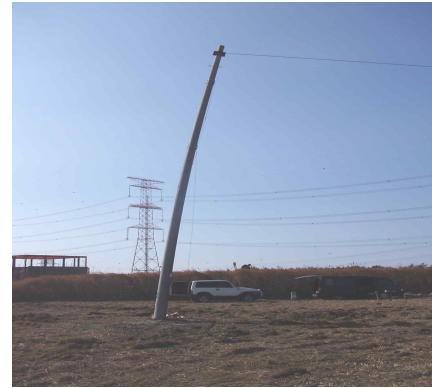
그림 1. 전주 인장실험 Fig. 1. Tensile test of electric pole
