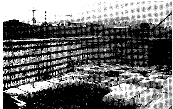
그림 4. SCW + Earth Anchor 전경
