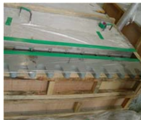
(c) 신축이음장치 설치
