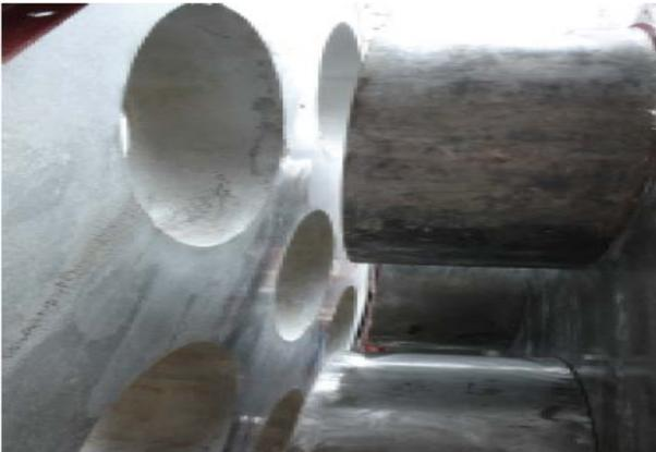
양생기간은 벽체의 경우 타설 완료 후 48시간으로 한다. 단 계절에 따라 유동성이 있으며, 그 기준은 강도측정기를 사용하여 탈형강도 기준 데이터와 비교한 후 작업한다. 탈형 이전에는 디비닥 볼트 및 핀 제거 작업만을 허용하며 콘크리트 면에서 거푸집을 직접 뜯어내는 것을 금지한다.
