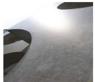
탈형 후 표면의 광택 및 오염 방지를 위한 코팅제의 종류를 시험하였다. 불소 침투성 발유/발수제와 불소 도막형 발유/발수제, 실리콘 아크릴계 발수제를 비교 시험한 결과 불소 침투성 발유/발수제를 사용하는 것으로 결정하였다. 광택의 경우 도막형이 더 유리하였으나 표면에 스크래치가 발생하였을 때 발유 및 발수 성능이 저하되기 때문에 침투성의 성격을 갖고 있는 제품(DuPont Zonyl 8740)을 선정하였다. 광택은 콘크리트 강도가 강하여 특정 샌더 패드를 사용한 숙련된 기술자의 작업과 세라믹 코팅제(고온산화방지용)의 사용으로 보완할 수 있으므로 발유/발수제 도포 전에 충분한 광택작업, 표면강화작업이 반드시 선행되어야 한다.
