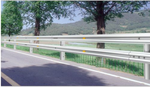
그림 2. 야생동물보호 겸용 잡초방지펜스 Fig. 2 Wild animals protective combination weed prevention fence
