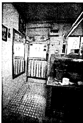
<사진 2> 사례 20 : 상가주택의 현관개조(외부턱 제거 - 경사로 설치)
