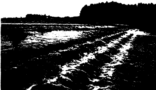
그림 9. 전면 어도식 개념을 도입한 지류의 하상유지공의 예
