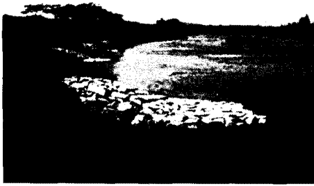
그림 10. 하안침식 방지를 위한 자연친화적 수제공법의 예
