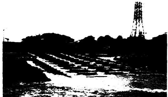
그림 9. 전면 어도식 개념을 도입한 지류의 하상유지공의 예
