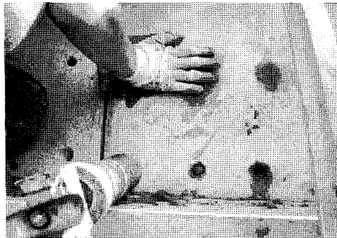
그림 6. 몰타르 충전식 철근이음 그라우팅 전경
