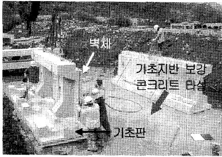
(a) 기초판 설치 및 벽체 조립
