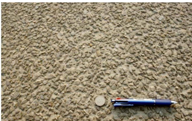
그림 19. 콘크리트포장 표면조직
